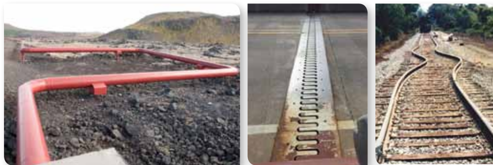
Мал. 236. Теплове розширення конструкцій
