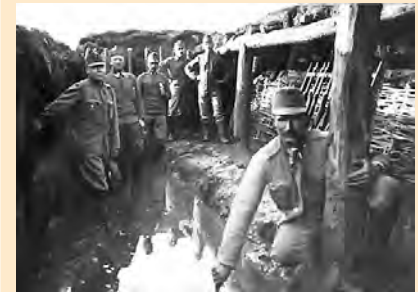
■ Австрійські траншеї, залиті водою
