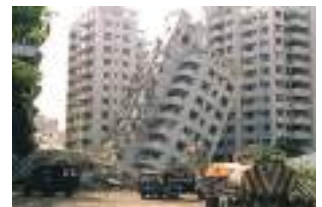
Іл. 40.15. Наслідки землетрусу
