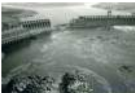
Іл. 40.8. Зруйнована вибухом гребля Дніпрогесу в 1941 р.
