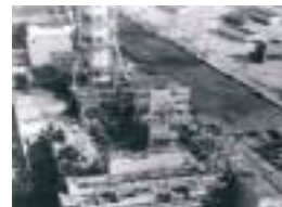
Іл. 40.10. Аварія на Чорнобильській АЕС
